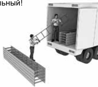
Рисунок 1 Разгрузка кабельных трасс
